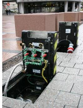
Die Unterflursysteme werden in zwei Größen und zwei Ausführungen angeboten. Bei der CAMPETTO V Ausführung handelt es sich um einen Tränenblechdeckel, bei der CAMPETTO VI Ausführung um einen bepfasterbaren Deckel.
