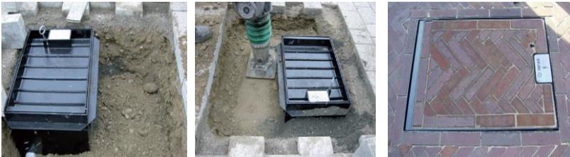
Baugrube befüllen und verdichten. Im oberen Bereich eine Betonmanschette anbringen (gem. Zeichnung Seite 2 + 3).
